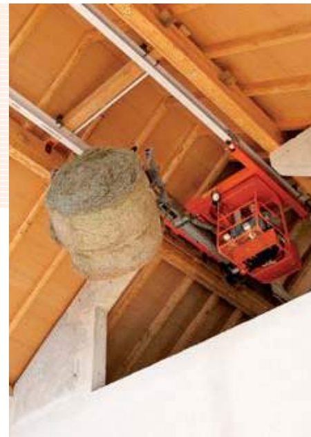
Kranspuren werden an das Gebäude angepasst
